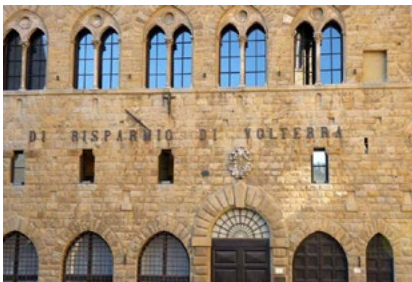
The headquarter of Cassa di Risparmio di Volterra
